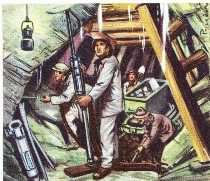
Intérieur d'un tunnel: les ouvriers creusent dans la roche avec des perforeuses. La voûte est soutenue par de grosses poutres, l'eau suinte sur les parois.
